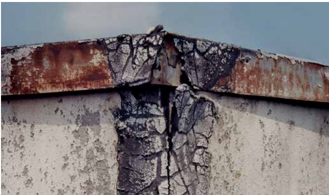
Deteriorating metal edge
